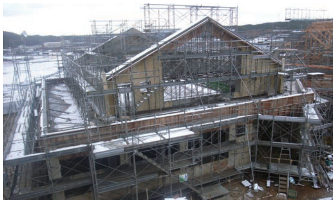
管理棟施工時
