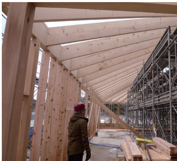
0～2歳児棟屋根根施工時
