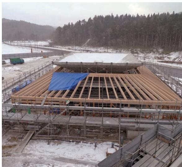
0～2歳児棟内観（施工時屋根架構）
