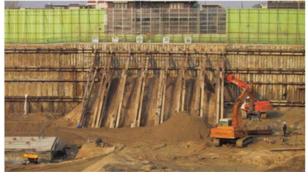
[단계별 Raker 시공현장]
